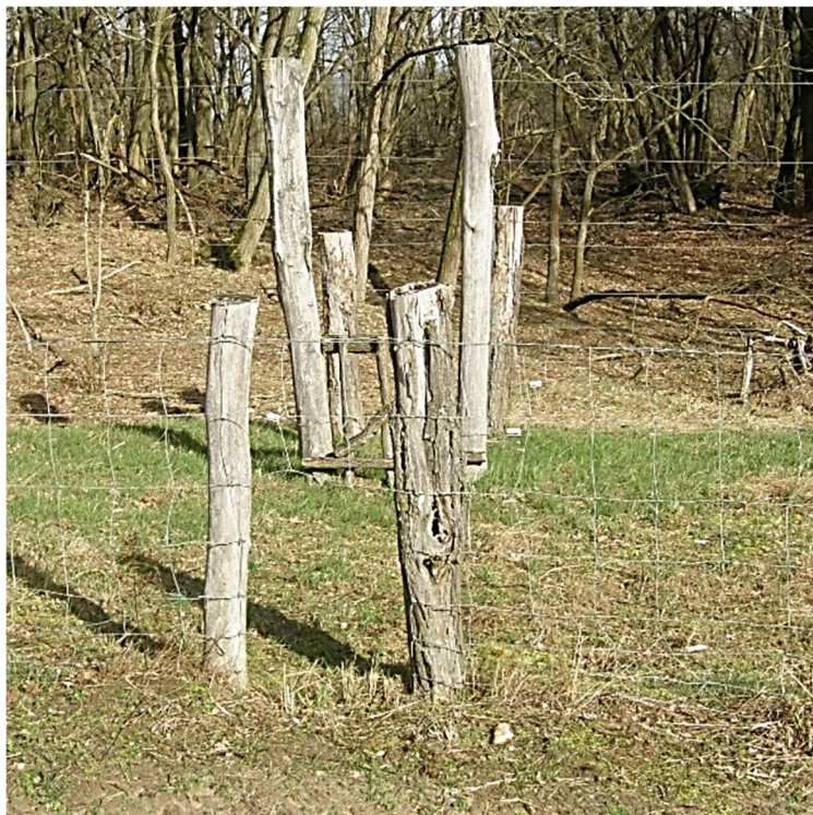
Abb. 2: Durchlass für Wildtiere bis zur Grösse von Wildschweinen und Rehen in der Döberitzer Heide (Foto © Peter Nitschke), ca. 60cm breit und 80 cm hoch.
