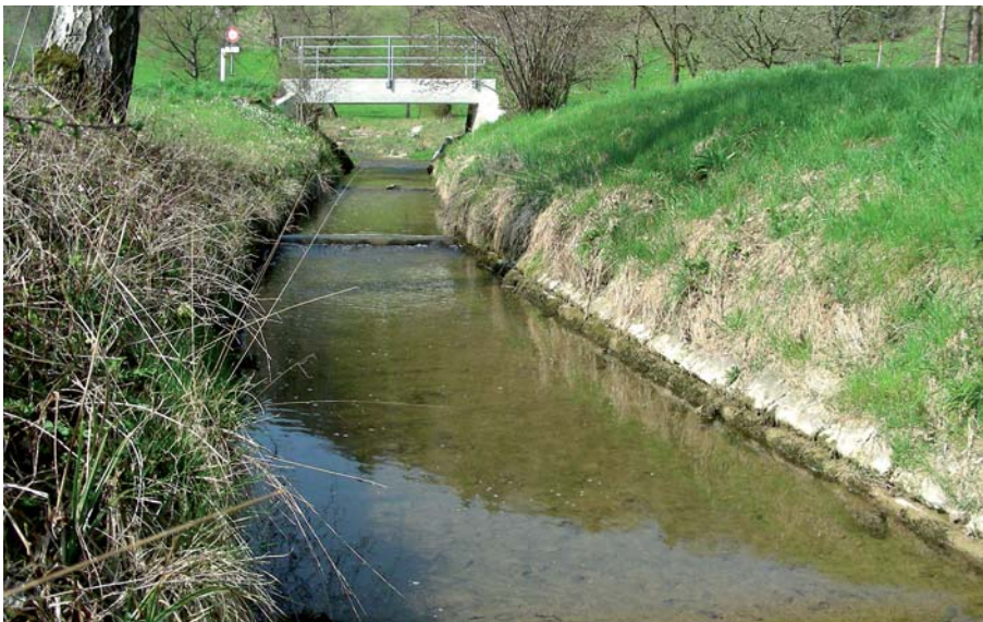
Bild 12. Hell, kanalisierter Abschnitt.
