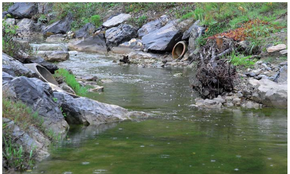
Bild 5. Bachstrecke Hell-Gamlikon, Drainageeinleitungen ohne Auflandungen.
