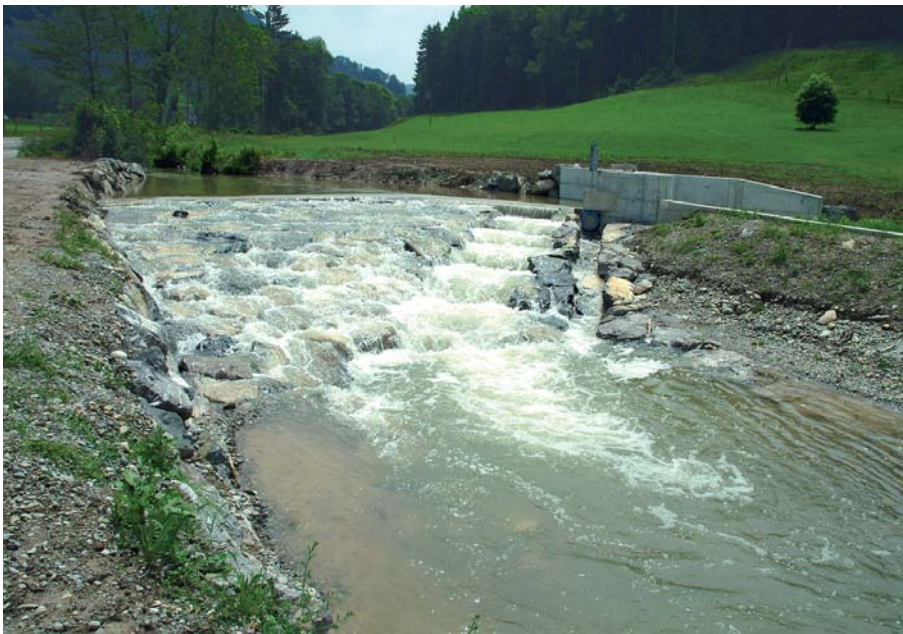
Bild 7. Wehr und Rampe der Wasserfassung Aumüli: Rampe bei Mittelwasser überströmt.
